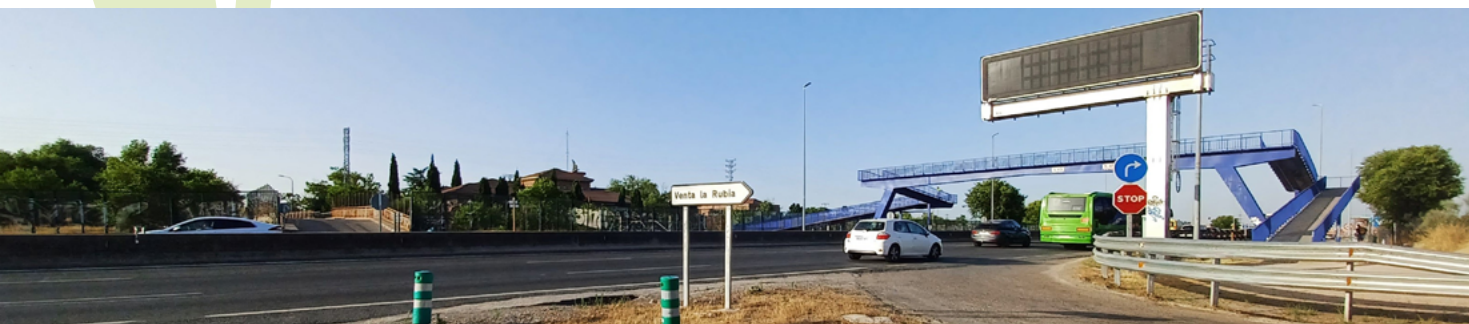
La pasarela sobre la A5 que conecta diversas Rutas Verdes
