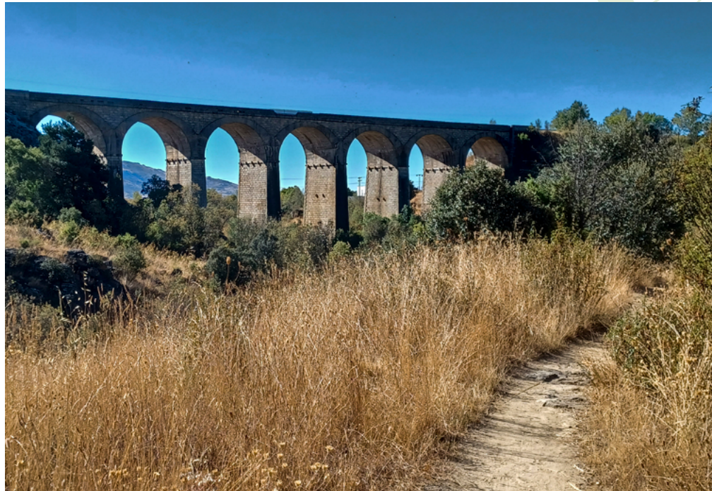
Viaducto del F.C. Madrid-Burgos
