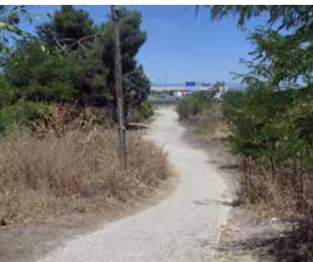
Tramo sin acabar
