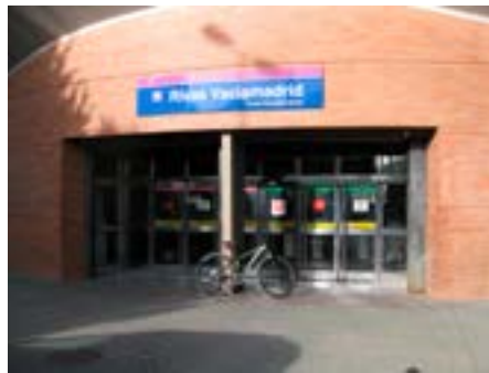
Estación de Rivas Vaciamadrid
